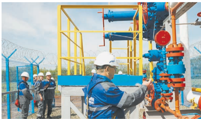
Идущая справа белая труба не покрашена в белый цвет, она во льду. На скважине, где поднимающийся с глубины под большим давлением газ надо перевести на меньшее давление, проявляется эффект Джоуля–Томсона.
