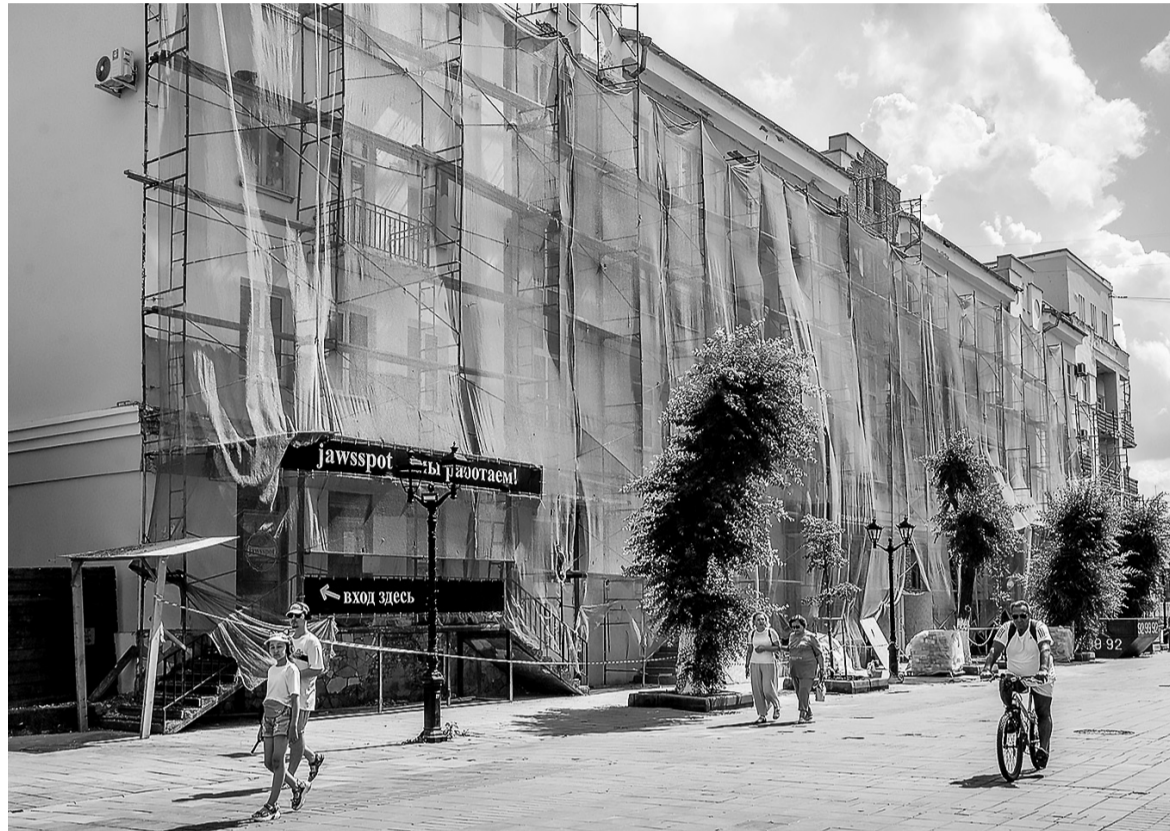
Большие реконструкции сейчас ведутся в исторической части Оренбурга.
