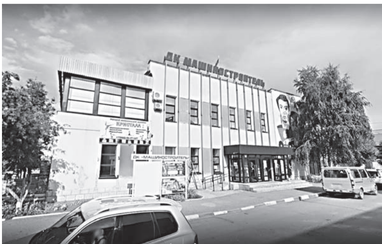
Капитальный ремонт Дома культуры «Машиностроитель» проходит поэтапно.
