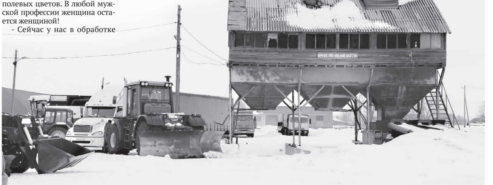
Мехтоку на базе КФХ Ивановой предстоит реконструкция.
