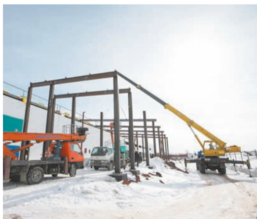
На площадке ОЭЗ в Оренбурге уже идет строительство.
