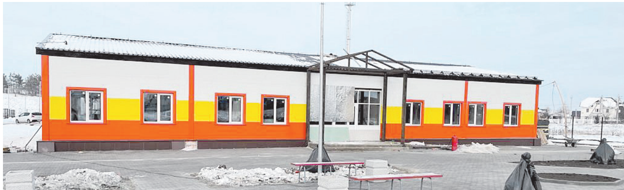
В селе Подгородняя Покровка идет строительство врачебной амбулатории.
